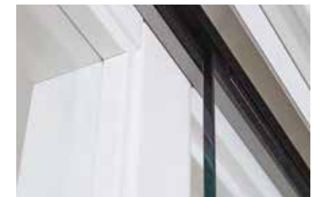
Befestigung einer Ganzglastür im Schiebetürbeschlag SLIM-Inlay
